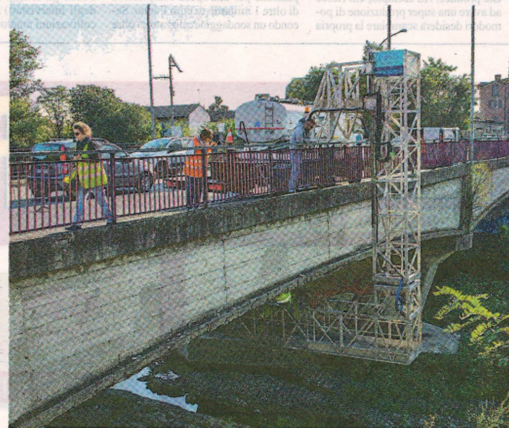
Gli addetti della ditta Gbrg impegnati nel monitoraggio sulla tenuta statica del Ponte Rosso
